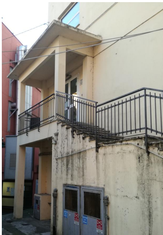
Figura 1.1 - Vista dell'ingresso alla scuola materna
