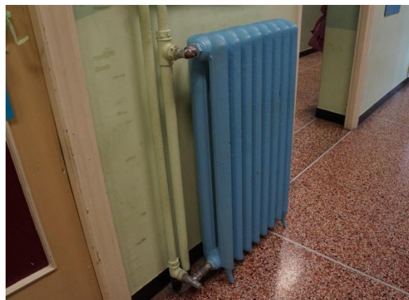
Figura 8.5 – Particolare terminali di emissione
