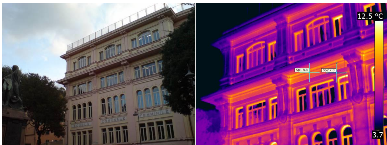
Figura 4.3 – Rilievo termografico della parete del fronte ovest
