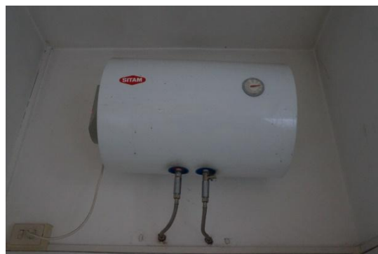
Figura 4.15 - Particolare di un boiler elettrico per la produzione di acqua calda sanitaria
