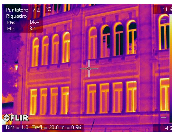
Figura 8.1 – Particolare termografia parete
